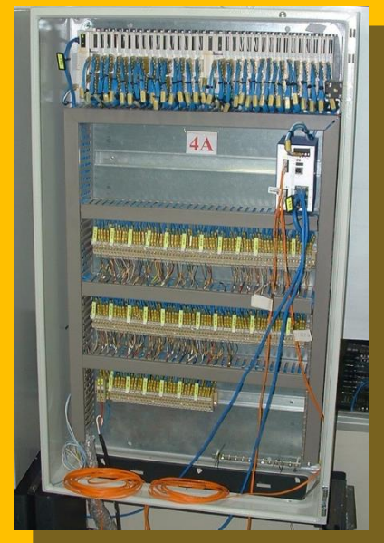
Remotas de Aquisição de Dados – Propulsão e Auxiliares
